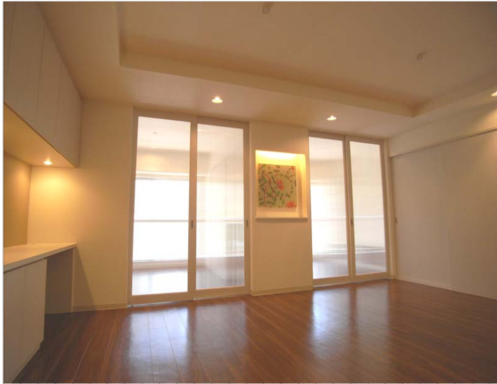
①暗くなりがちで、中リビングを半透明の引き込み戸によって採光を確保しました。正面には、季節感が味わえる様なディスプレイができるニッチカウンターを設けています。
